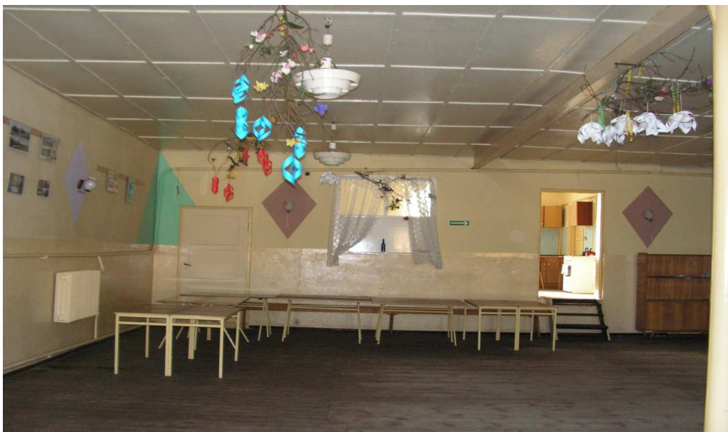
Stan świetlicy wiejskiej wewnątrz
