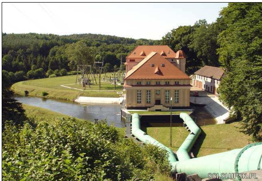
Elektrownia wodna w Gałąźni Małej
